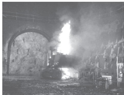
Feu sacré sur le chantier du TGV
